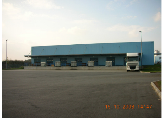
Große Lagerhalle mit Laderampen und Sektionaltoren
